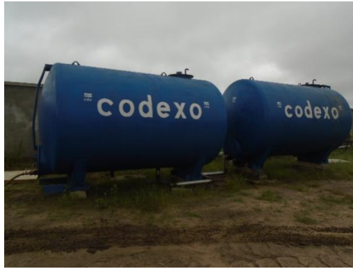
Photos 4 et 5 : Système de gestion des déchets d'huile
